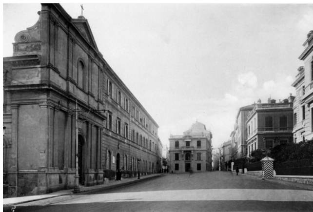
Façade sur la Place de la Visitation.
